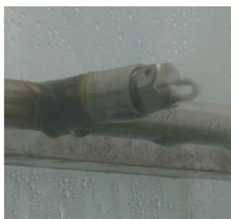
14B : buse à aiguille du fog système
